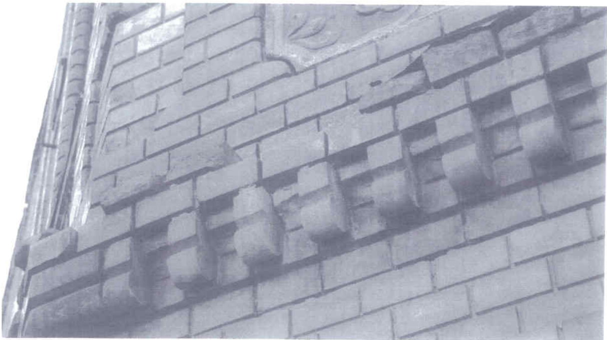
A lefagyott – törött - elpusztult téglapárkányok egyrészt cserével, másrészt pótlással és kőrestaurátori téglakiegészítéssel javíthatók.
