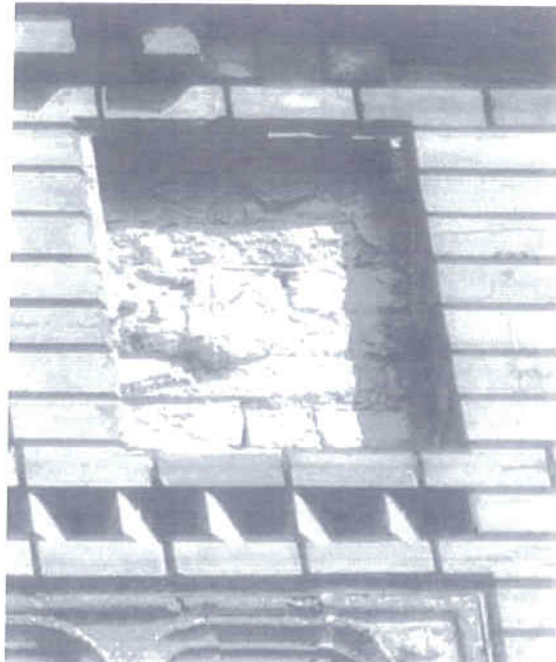
Újra készítendő stukkótábla helyek és egy lehetséges mintatábla
