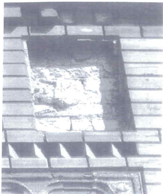
Újra készítendő stukkótábla helyek és egy lehetséges mintatábla
