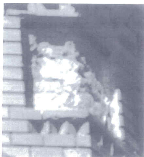
Újra készítendő stukkótábla helyek és egy lehetséges mintatábla
